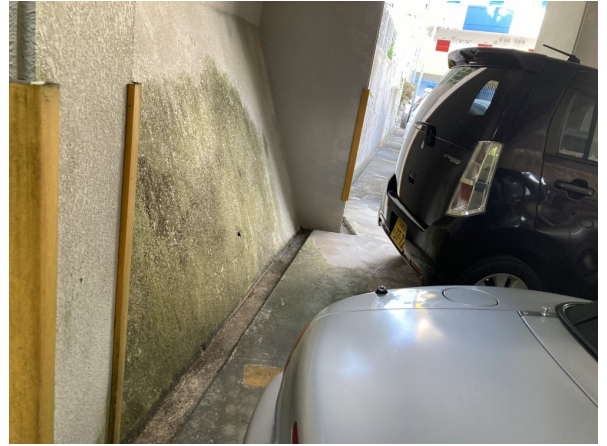
1. 駐車場・駐輪場
