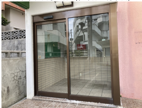
3.エントランスホール（タイル・ガラス）
